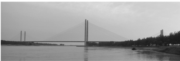
(a) 山东滨州黄河公路大桥
